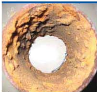
ก่อนการติดตั้ง (18 สิงหาคม 2550)
