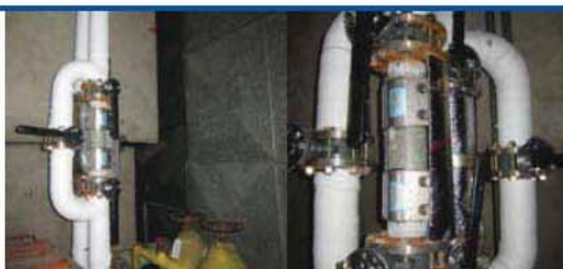
การติดตั้งอุปกรณ์เพื่อการตรวจสอบ
