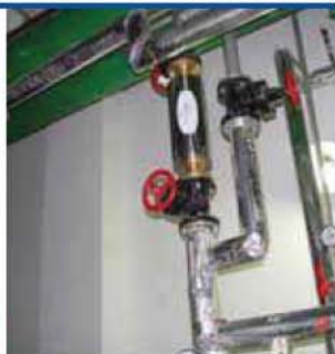
หลังการติดตั้ง
