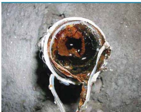
ท่อเกือบที่จะตันจากการสะสมของตะกรัน
