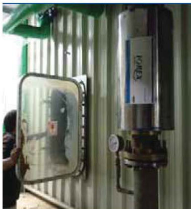
ส่วนงานควบคุมอากาศ AHU ใช้งาน IOREX (100A)
