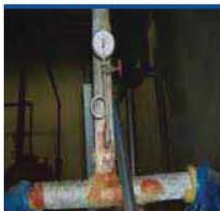
ก่อนการติดตั้ง
