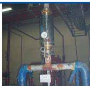
หลังจากติดตั้ง
