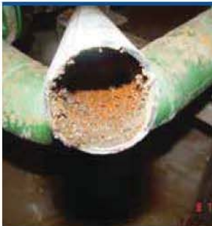
ก่อนการติดตั้ง
